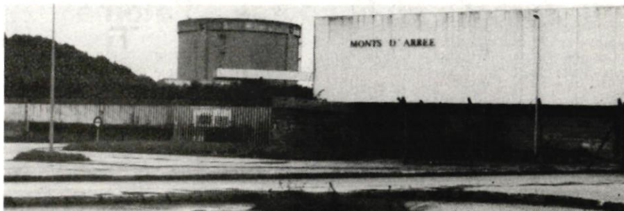
La mini-centrale de Brennilis, dans les Monts d'Arrée : fermée en 1985, elle imposera son dôme et ses radiations pendant des siècles.
