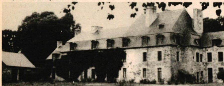
Forges du Vaublanc (Plémét). Logis du maître de Forges.
