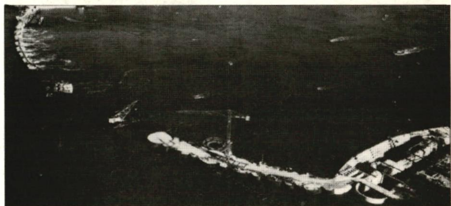
La marémotrice de la Rance en construction.
