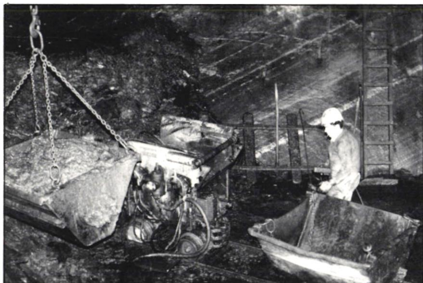
Le fond. Au centre, la machine d'extraction. Aux extrémités, deux «bassicots»; l'un qui monte, plein, l'autre prêt à charger.
