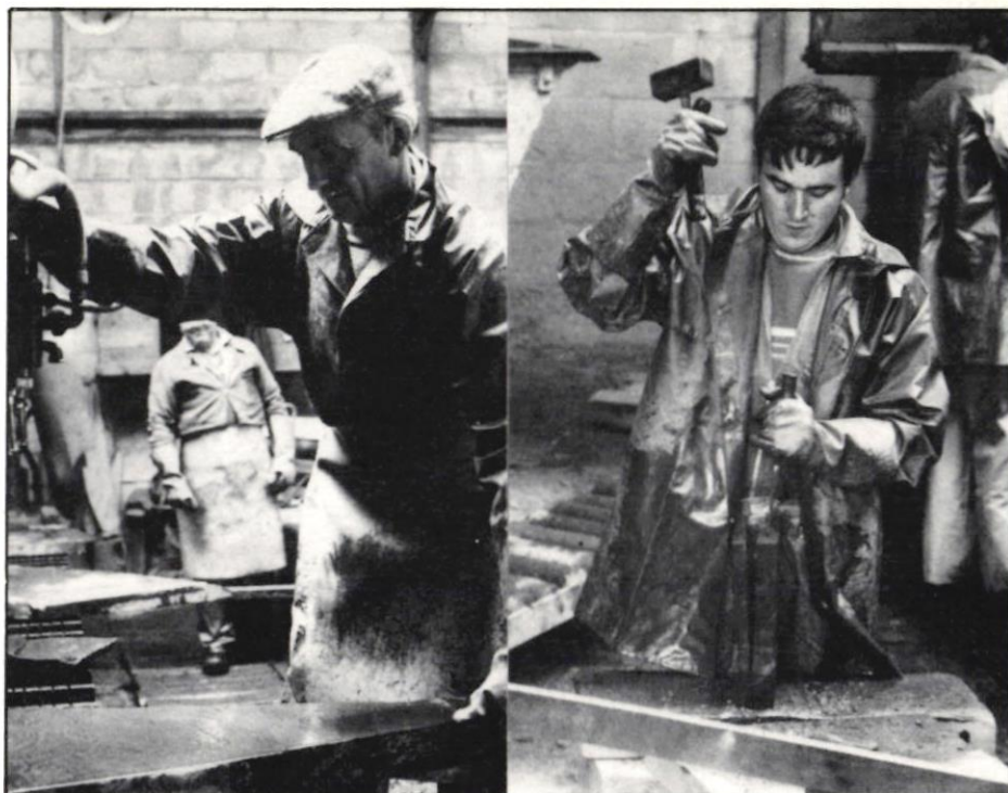
Après le fond, le débitage (l'air comprimé, l'eau et l'électricité sont utilisés) et le quarryage, au jour. Suivra le fendage.
