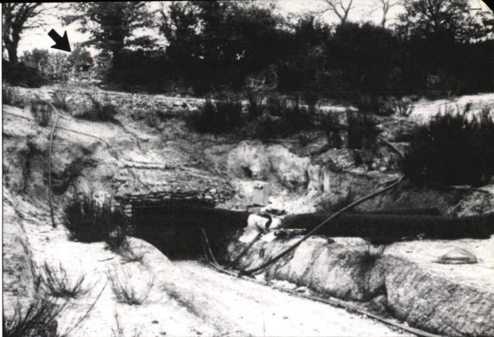
Entrée de la galerie de la Croix-Villeneuve. La flèche indique la cheminée d'aération de la mine.
