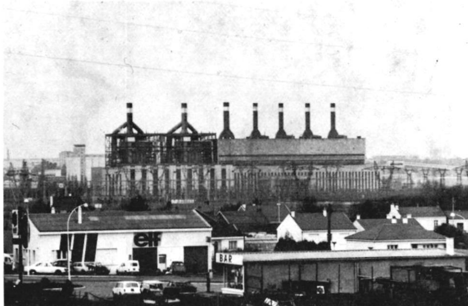
« Le paradoxe d'une région exportatrice d'énergie très mal servie elle-même », la centrale E.D.F. de Cheviré/Nantes.
