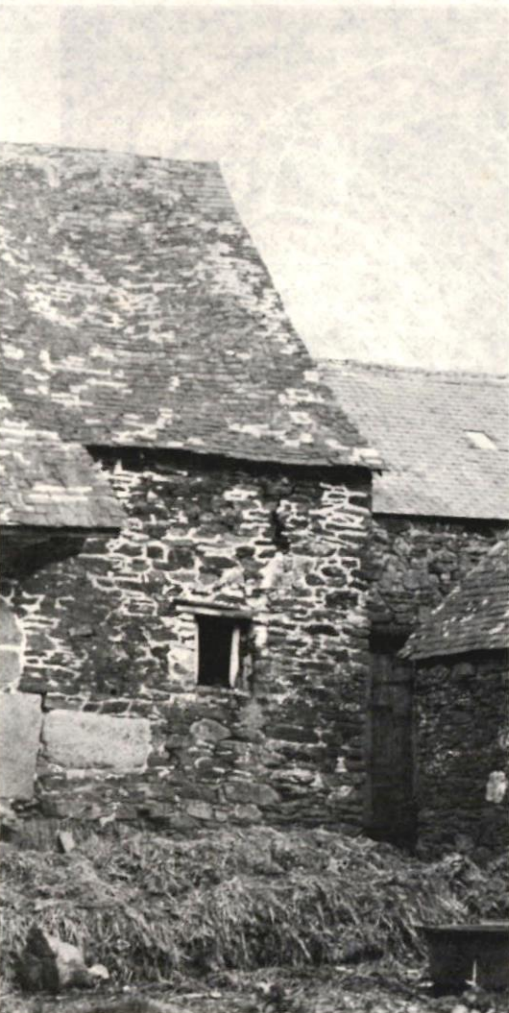
Brasparts : maison à Kerivarc'h. Un bon exemple d'apothéïs dans le centre du Finistère. Remarquez les contrastes : dimensions des pierres d'entourage de la porte, le toit sans presque aucun accident. L'auvent n'a pas l'air d'avoir été rajouté après coup. Toute la qualité de cet exemple est dans ses proportions.
