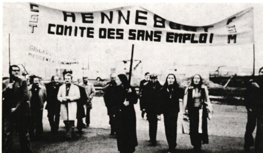
100 000 chômeurs en Bretagne : c'est une année très mauvaise non seulement parce qu'il y a des chômeurs, mais parce qu'ils partent.
